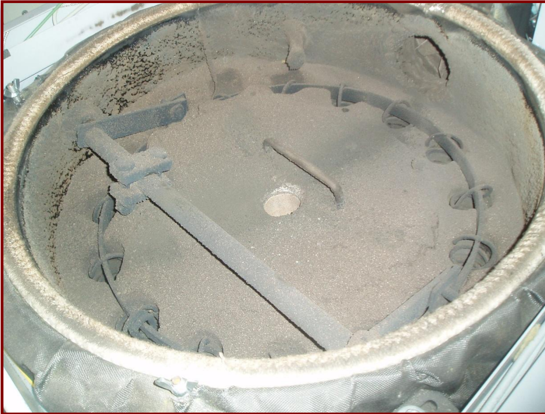
Caldera 20 kW con 1200h funcionamiento antes de limpieza anual
