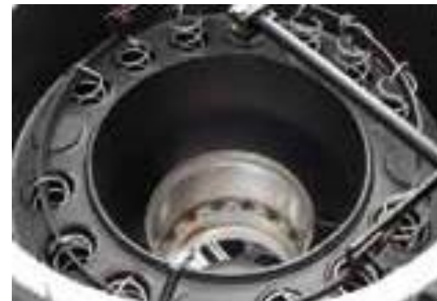
Caldera 20 kW con 1200h funcionamiento antes de limpieza anual
