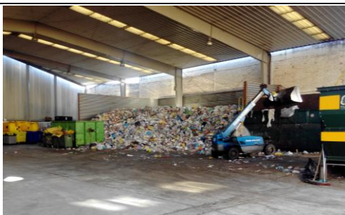
Zona de Recepción de residuos y Alimentación al abridor de bolsas en el Centro de Recuperación y Reciclaje de Candina
